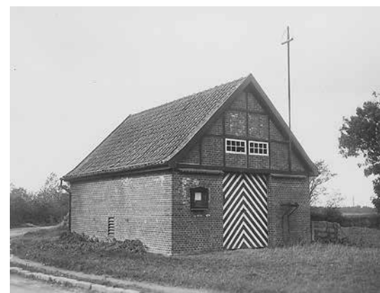
Das alte Gerätehaus der Feuerwehr an der Büsumer Straße (Foto oben) steht schon lange nicht mehr. 1962 wurde ein neues Gebäude am Kirchenweg erbaut. Ganz aktuell ist der Neubau an der Bahnhofstraße.
