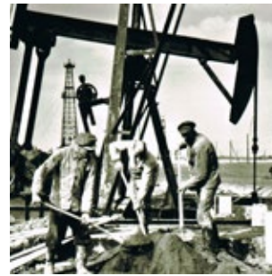
Eine Bohrung war fündig, eine Pferdekopftiefenpumpe ist in Betrieb
