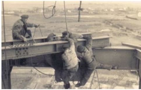
Balanceakt beim Bau der Krackanlage.
