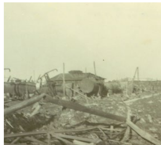
Starke Schäden nach Bombenangriffen aufs Erdölwerk 1944.
